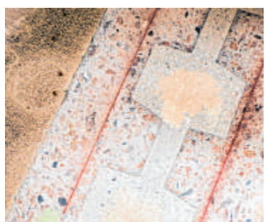
Wo zwei Betonplatten aneinanderstoßen konnte bislang Wasser eindringen. Die Betonsanierer haben abgedichtet.
