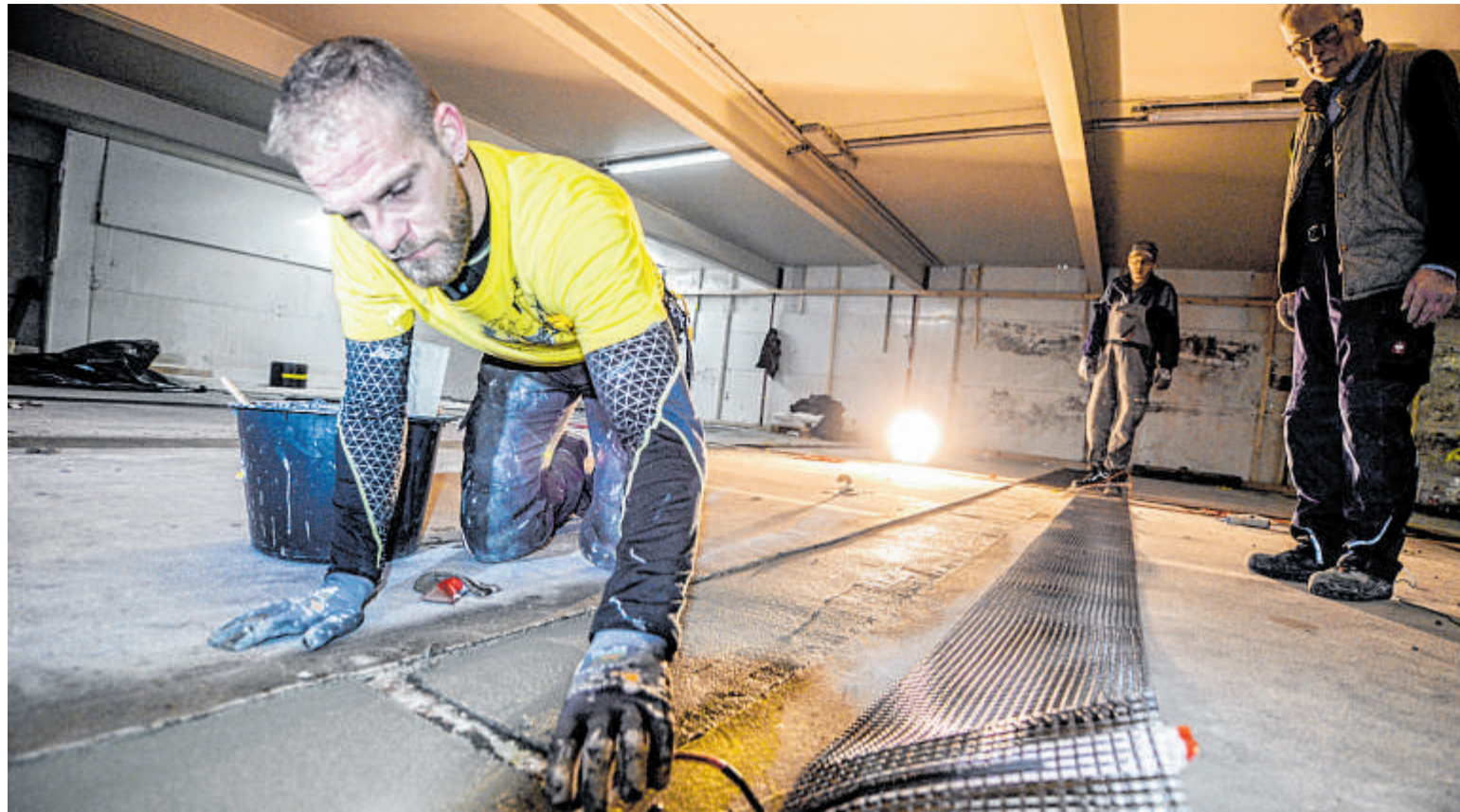
Betonsanierer Patrick Hoffmann verlegt im Löhrtor-Parkhaus die Carbon-Matten in Spezialmörtel.
