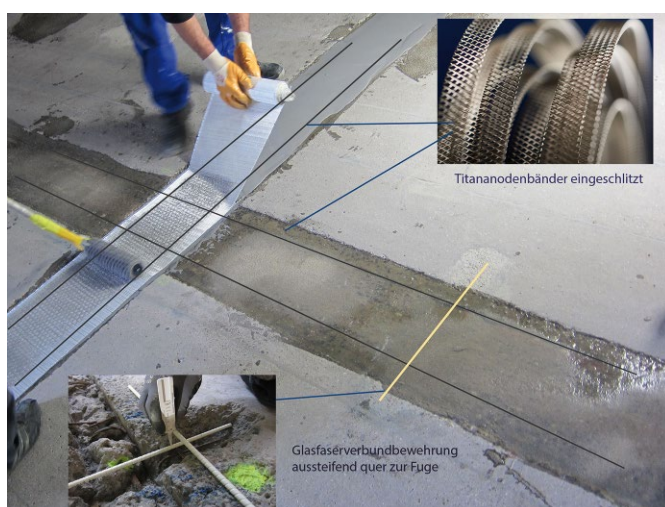
Bild 3 Verlegung der Rissbandage auf KKS-geschützten Fugen mit Bewehrungsergänzung durch Glasfaserverbundstäbe
