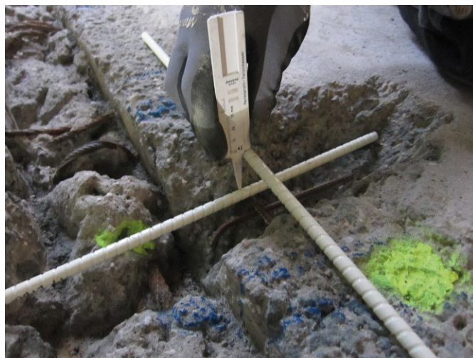
Bild 2 Nahaufnahme der Verstärkungsnut beim Einlegen der Glasfaserverbundbewehrung
