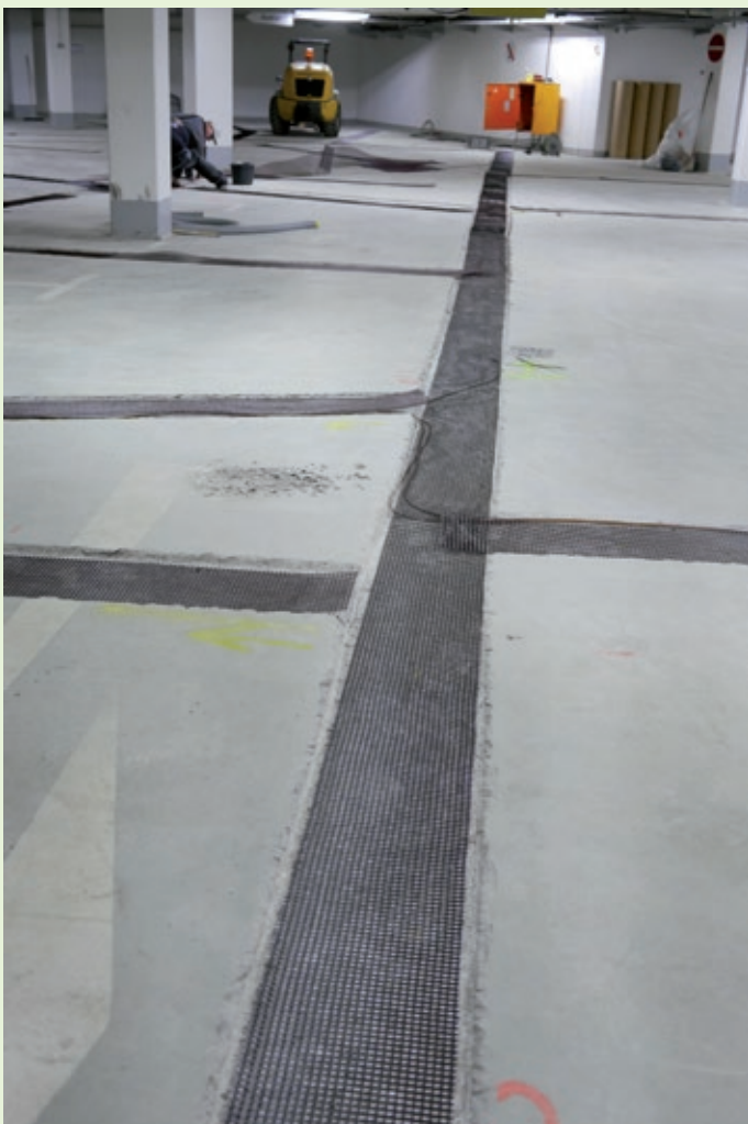
Rissanierung mit KKS-Carbonbeton
