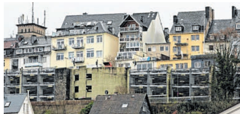
Die Hanglage des Parkhauses Markt machte während der sechsmonatigen Arbeiten erhebliche Sicherungsvorkehrungen nötig. ARCHIVFOTO: CORNELIA SUHAN/DISBON
