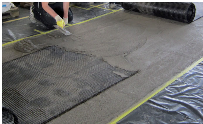
Bild 2 Selbstnivellierender KKS-Mörtel mit zwei Lagen Gewebe
